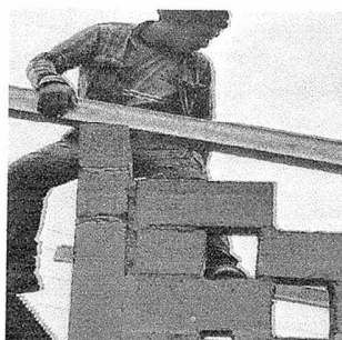
Foto 4: Se observa el avance de la estructura portante en el modulo 2.
