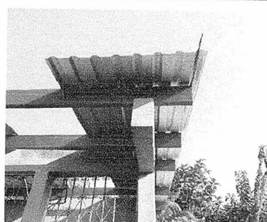
Foto 2: Se observa el avance de la cubierta de láminas portante en el modulo 1.
